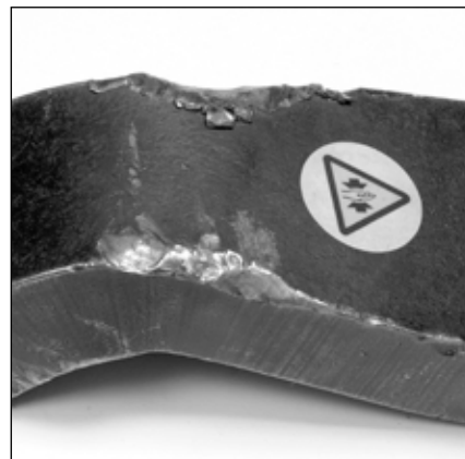
На поврежденной опоре видны признаки неверно принятой реакции. Реакция была принята опорой в несоответствующей точке, а зазор указывает на то, что опора соскользнула с точки реакции.
