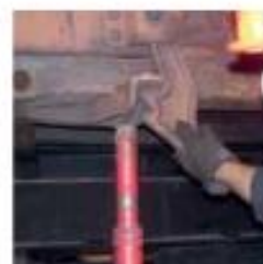
Правка угольника и закрытие замков
